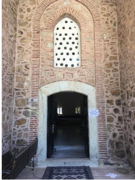
Resim 7. Mevlevihane ön cephesi (2017) Resim 8. Mevlevihane kapısı (2017)
