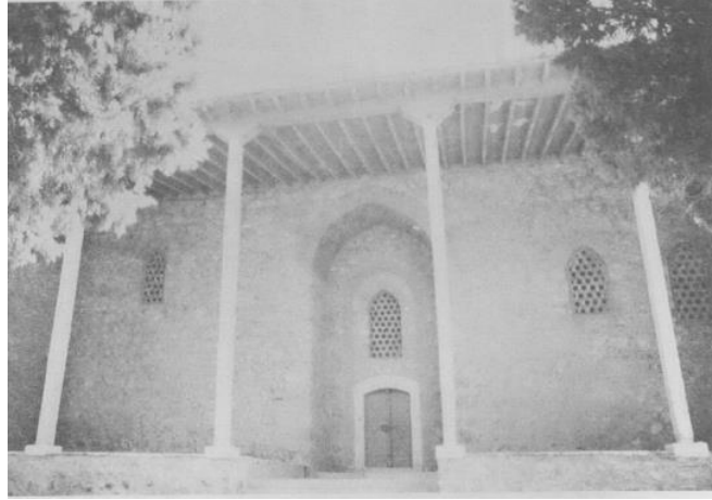
Resim 4. 1960 Restorasyonu sonrası Mevlevihane (Acun, 1999)
