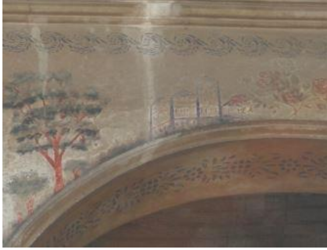
Resim 17: Soma Damgacı Camii son cemaat yeri revak kemerlerinden ayrıntı.
