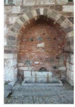
(Şekil.5:Ulu Cami Medresesi Çeşmesi 2'ye eski yeni karşılaştırması)
