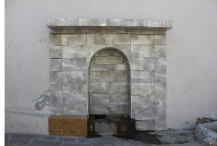
(Şekil.44: Serseri Dede Çeşmesine ait eski yeni karşılaştırması)
