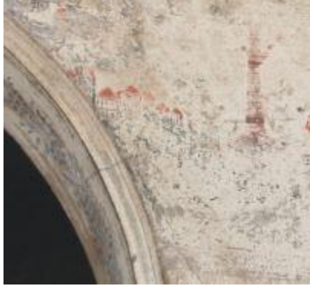
Resim 19: Soma Damgacı Camii son cemaat yeri revak kemerlerinden ayrıntı.
