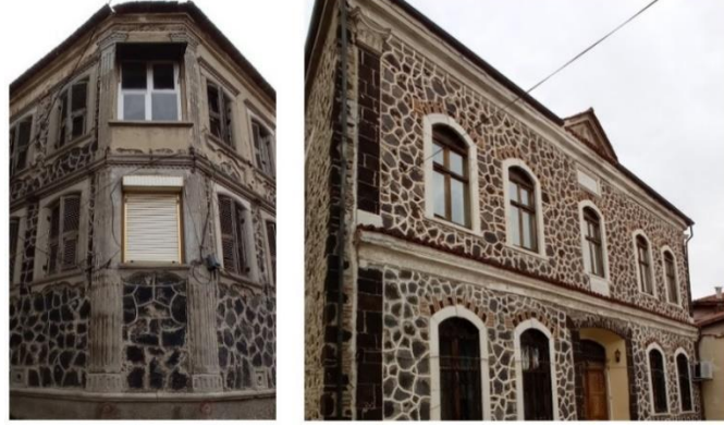
Şekil 13. Kula'da bulunan Rum Evi süslemeli cephe elemanları. Solda Rum Evi köşe pilastırı, sağda Rum Evi kat silmesi (Eymen Tatlıhalat Arşivi-2022).
