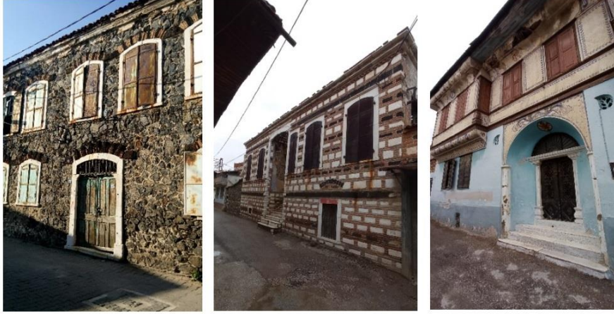
Şekil 3. Kula'da bulunan Rum Evi yapım sistemi örnekleri. Solda yığma taş sistemle oluşturulmuş Rum Evi, ortada kesme taştan almalı olarak oluşturulmuş Rum Evi, sağda sıvanmış cepheli Rum Evi (Eymen Tatlıhalat Arşivi-2022).
