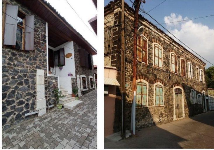
Şekil 2. Kula'da bulunan Rum Evi farklı kat örnekleri. Solda, tek katlı Rum Evi, sağda İki katlı Rum Evi (Eymen Tatlıhalat Arşivi-2022).
